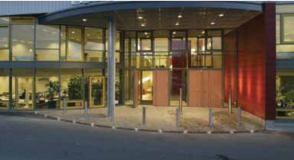
ACO DRAIN® ved indgangen til firmaet Mobilcom i Büdelsdorf, Tyskland.
